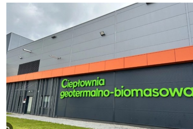
Ciepłownia geotermano-biomasowa w Sieradzu (źródło: LM.PL Globenergia)
